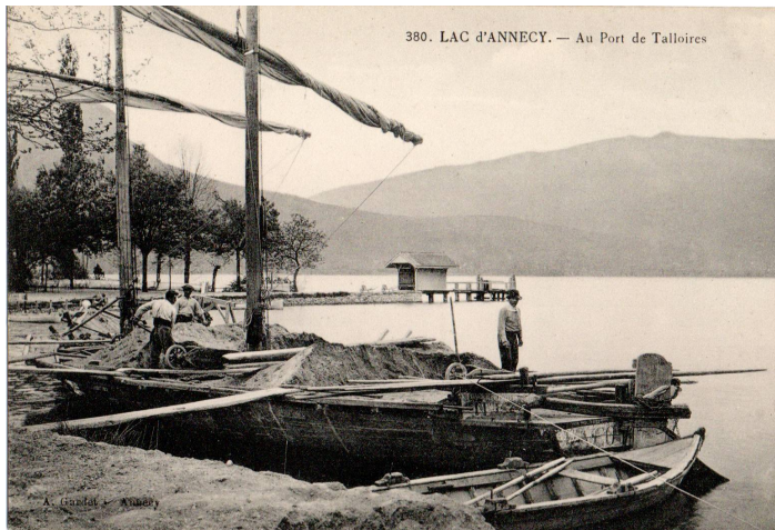
Déchargement de sable à Talloires. Durant leur transport, les tas de sable étaient retenus par des pièces de bois disposées au-dessus des pièces enco- chées : les fargues
